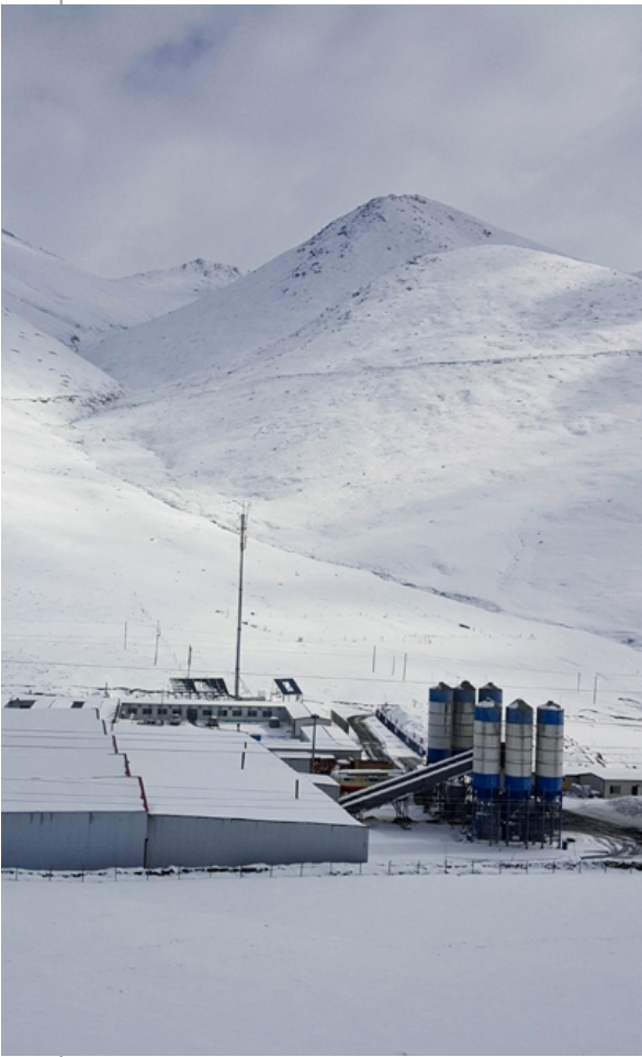
▲大雪中的陕西路桥花久项目部
